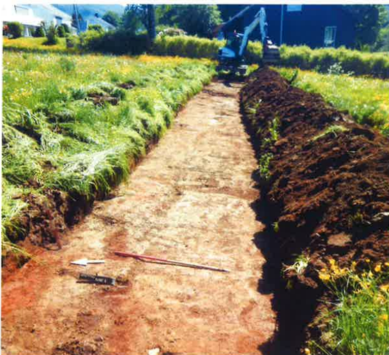
Figur 24. Sjakt E, sett mot sørøst
