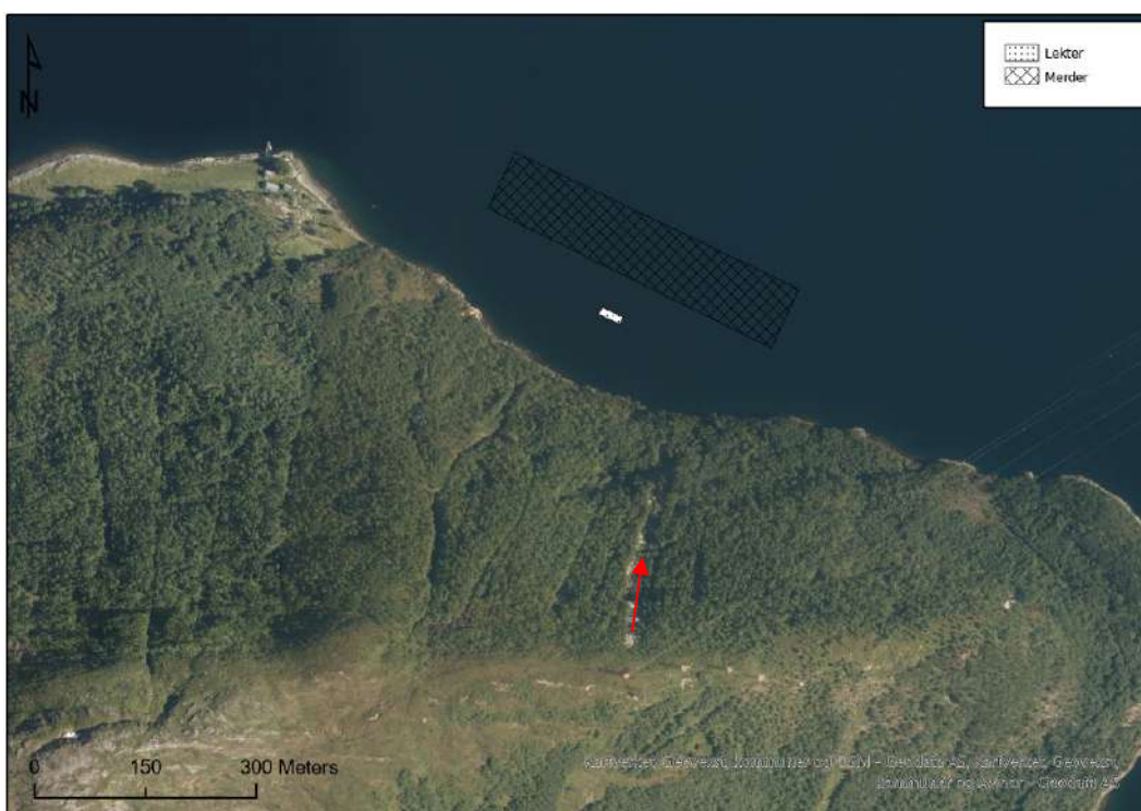
Figur 2-3. Flybilde fra 2018. Spor etter jordskredhendelsen i 2016 synlig som vegetasjonsfritt område.
