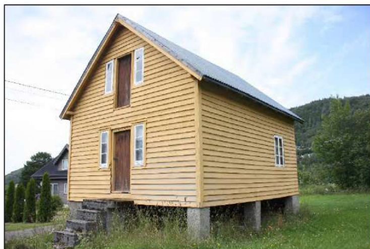
Figur 40 Stabburet har stabber av betong på østsiden.
