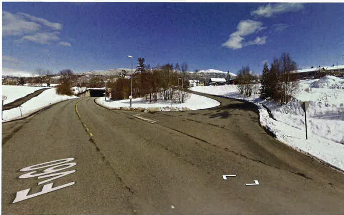
Figur fra finn.no, Kryssområdet mellom Fv60 og forbindelsesveg til Kyrkjevegen.
