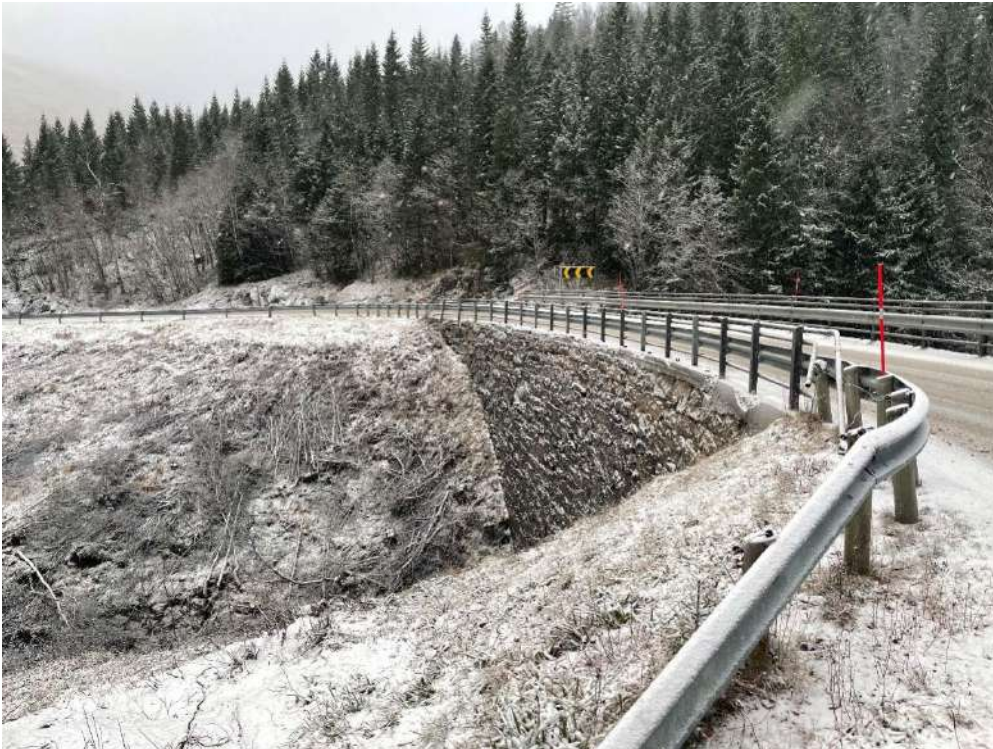
Bilde-1 Oversiktsbilde nedstrøms, sett fra øst.
