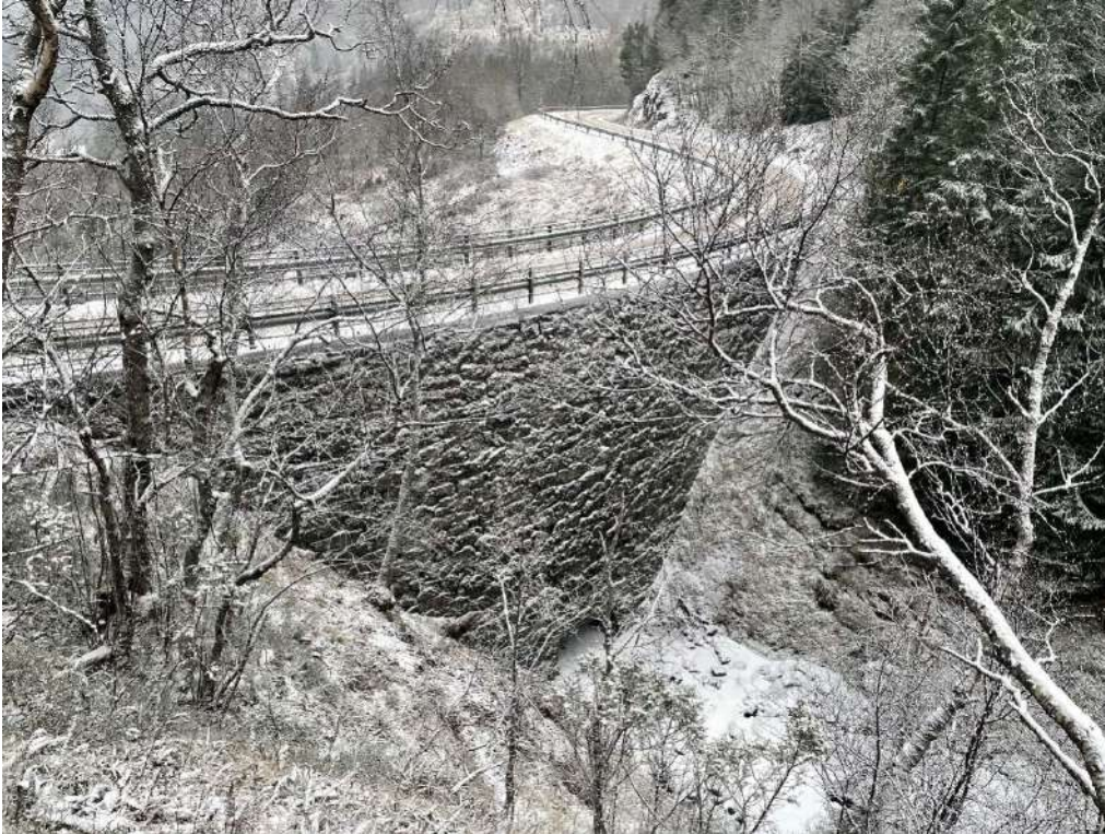
Bilde-5 Oppstrøms side av bru.
