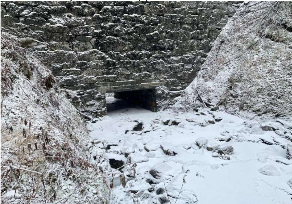
Bilde-6 Innløpet sett fra oppstrøms side
