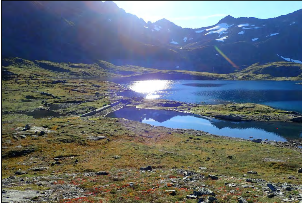
Storevatnet HRV: 733.9, LRV: 704.9. Inntaksmagasinet til Riksheimdal kraftstasjon. Terskel med overløp midt i bildet. Storevatnet er på ca. kote 730 ved bildetakning.
