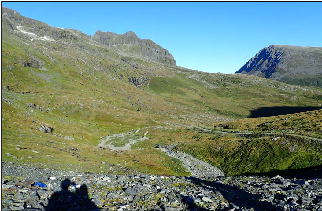
Bilde tatt nedover dalen fra ca. kote 670. Elveleie uten minstevannføring midt i bildet. Veien sees til høyre i bildet. Vannveien ligger nedgravd ved siden av rør og skjules godt i terrenget.
