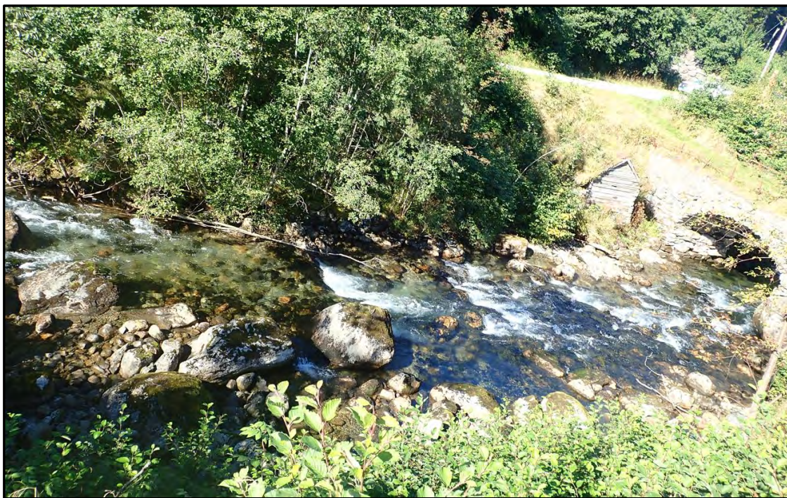
Elveparti. Ca. kote 15, like oppstrøms Fylkesveien. Gammel steinhvelvbru til høyre i bildet
