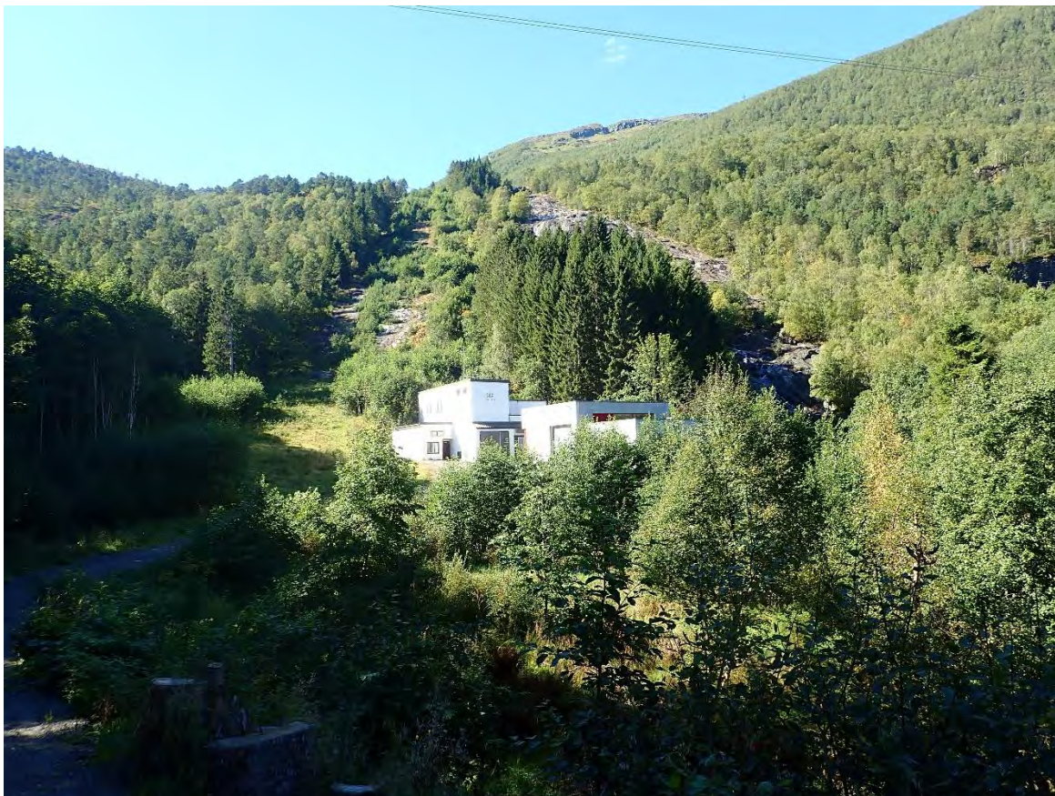
Figur 4-5 Riksheim kraftstasjon. Eldre stasjon til høyre, nye Riksheim foran til venstre.
