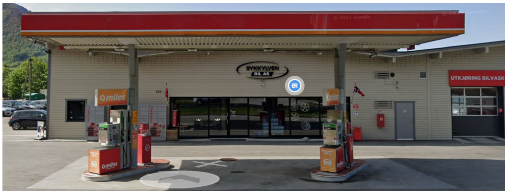
Fig. 1: 2 stk pumper med bensin og diesel mot Kyrkjevegen
