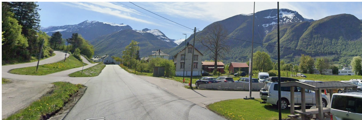
Fig. 1: Busslomme Sykkylven bensinstasjon
