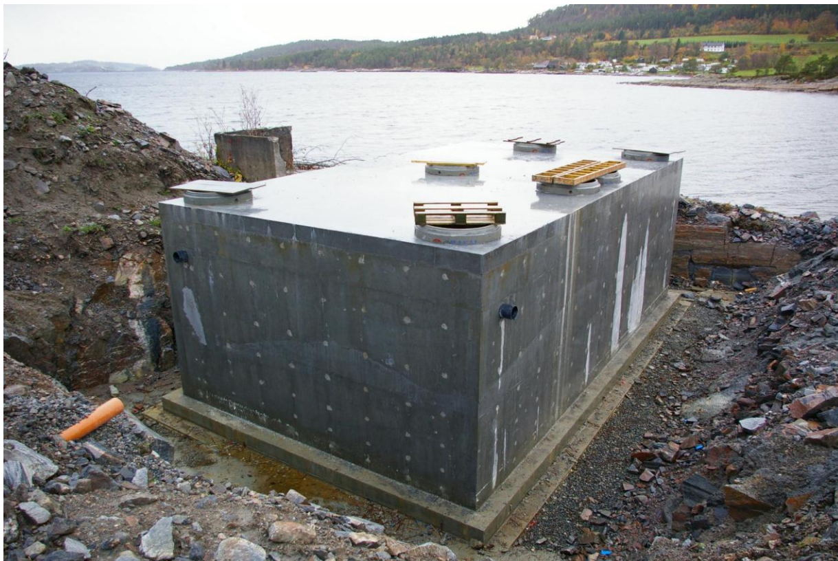
Eksempel på stor, felles slamavskiller under bygging (Skåla, Molde)
