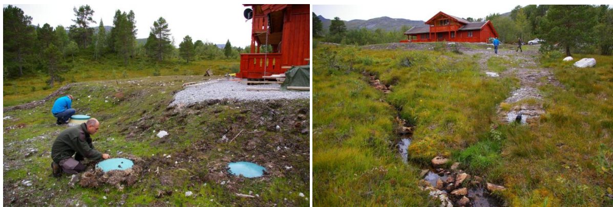
Figur 4: Kontroll av rensesanlegg for hytte. Avløpsanlegget består av slamavskiller, pumpekum og filterkum med Leca, med utslippsledning ned mot en mindre bekk.
