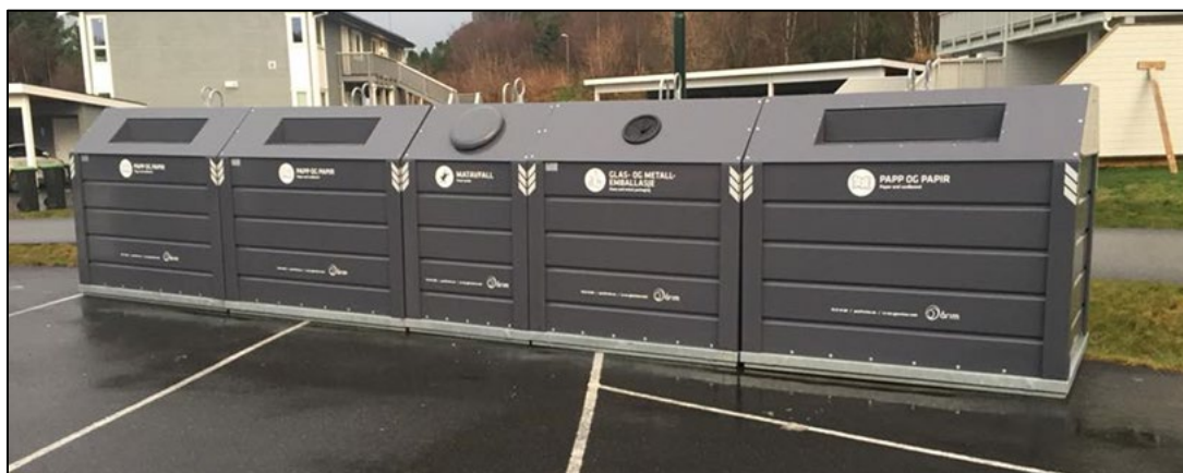
Figur 5.6 Bakkeplasserte bunntømte containere.
